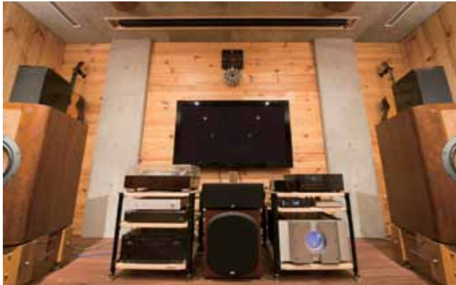
正面にあるコンクリートの2本の柱状の部分は坂本さんのリスニングルームの基となっている部分。部屋全体が200cm厚のコンクリートで構成されているのに対し、この部分はさらに厚くしてある
