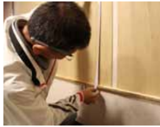
まずベニヤ合板の上端をカットして高さを169.5mmにしたものを3枚、間隔を空けて貼り、そこに12mmの白樺合板を21mmの高さに切り揃えたものをワクとして取り付ける
