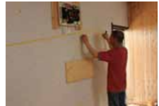
カイザーサウンドの実験室でもあるオートローゼンの山田さんのリスニングルーム。今回は左チャンネルのスピーカーの左側に音響パネルを製作。まずは「ここにボードを作る」という形をテープでつくる
