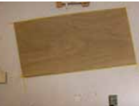
テープをもとにベースとなる板をサイズ通りに貼る。良く見ると四隅の角度が全部微妙に変えてある。素早く振動移動させるためらしい
