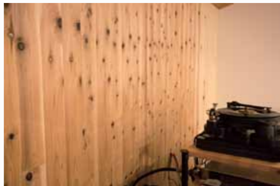
前面に設置された「志賀高原原木杉オーディオ壁」。直径50cmほどの1本の原木から年輪の順番に従い戸籍管理をしたうえで裁断。写真から木の節の部分がきれいに連続している様子がわかる
